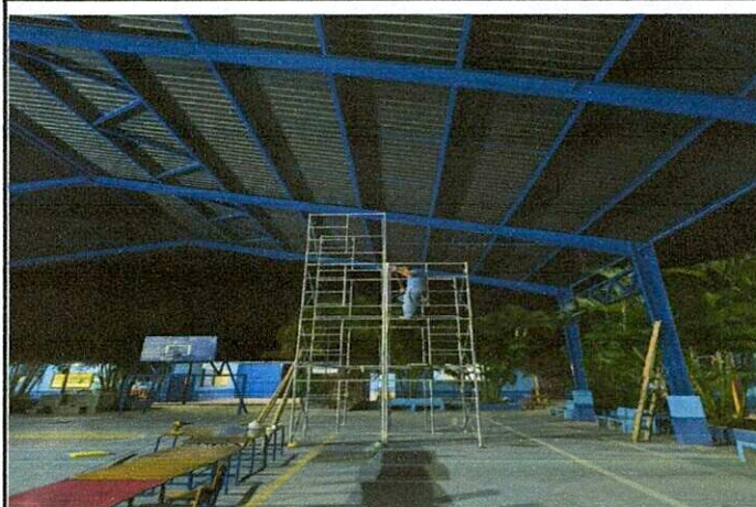
Foto 6: Reparación de cableado cancha
