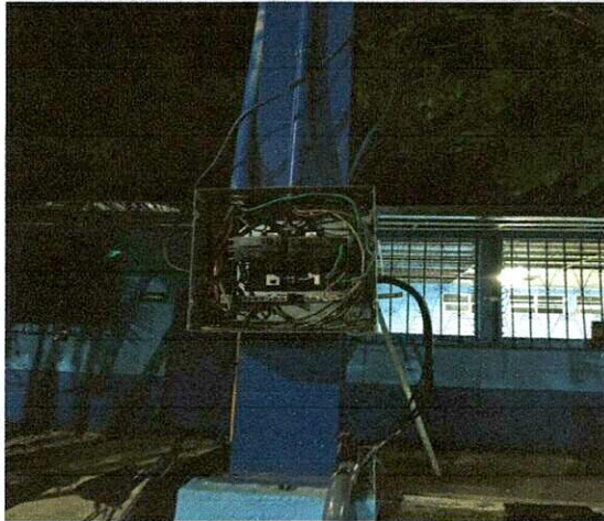
Foto 1: Reparación de energía de caja principal
