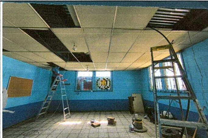
Foto 3: Cambio de cableado alumbrado en dirección
