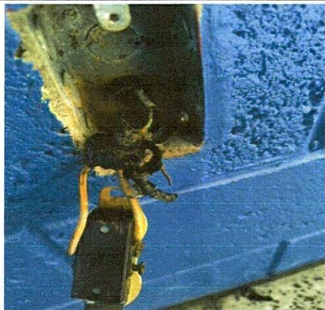
Foto 5: Reparación de toma corriente eléctrico
