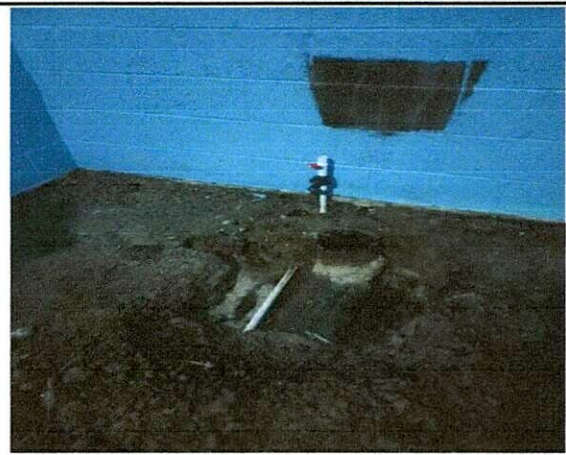
Foto 4: Reparación del sanitario y lavamano de dirección.
