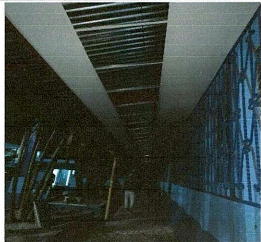
Foto 2: Cambio de cableado corredor de aulas
